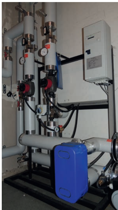
Fernwärme Anschluss
