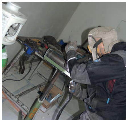
Heizzentrale im Aufbau
