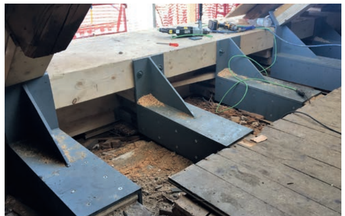
Balkenverstärkungen aus Stahl
