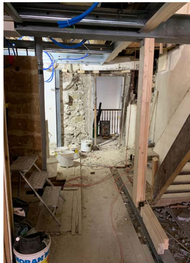
Der Blick aus dem Vereinslokal während der Rohbauphase
