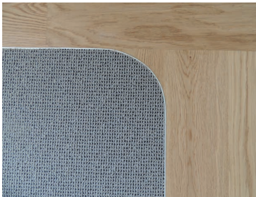
Parkett und Teppich sauber verlegt
