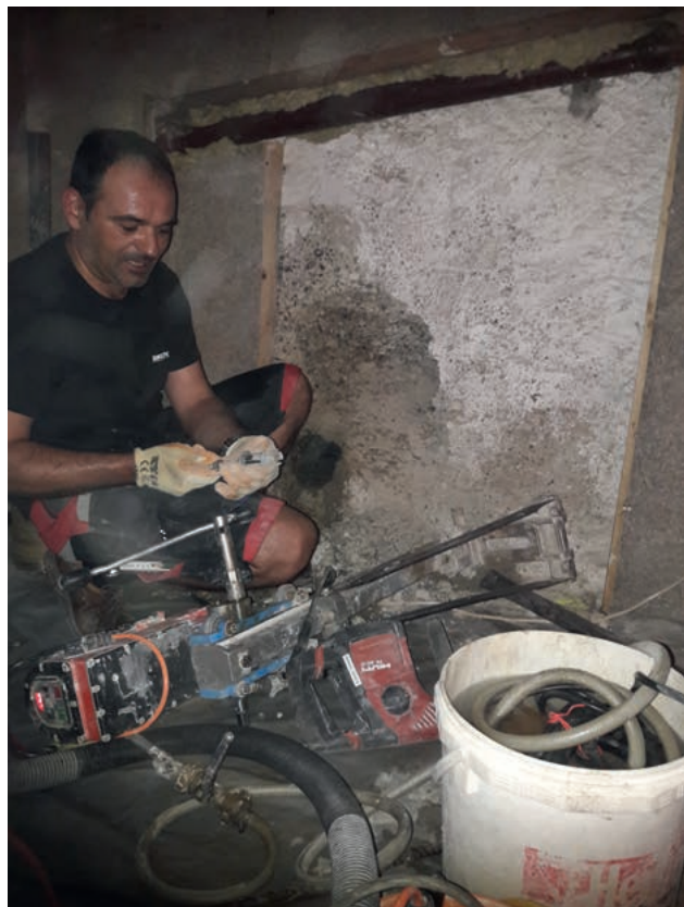
Die Bohrarbeiten kommen voran
