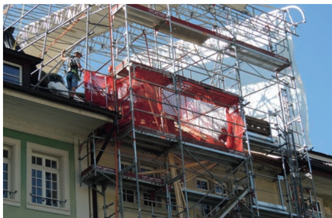
Schutzdach im Aufbau
