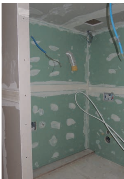
Raumverkleidung mit Gipsplatten
