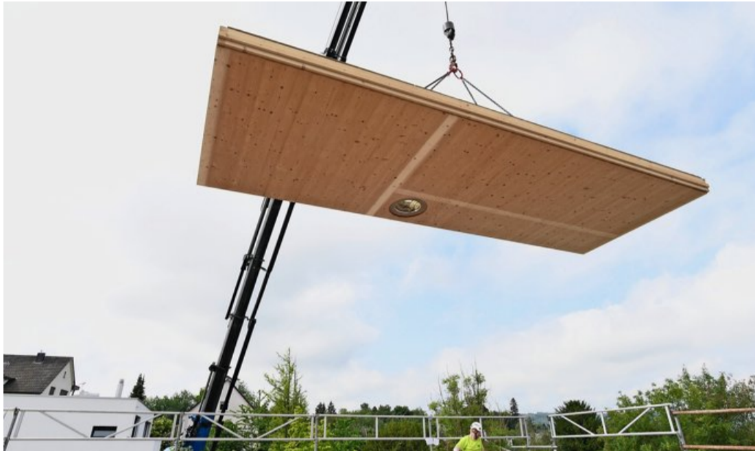
Oben links: Das Obergeschoss des Elementhauses ist ohne Dach. Oben rechts: Die Bauleute schrauben die Wände auseinander. Unten links: Ein Dachteil hängt in der Luft. Unten rechts: Die Fensterfront ebenso.
