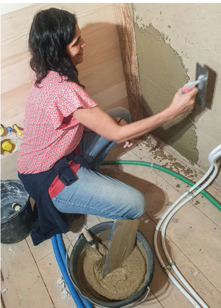
Lehmbauarchitektin Doris Müller arbeitet gerne mit Lehm, den sie vor der Haustüre eines Bauprojekts findet. In der Regel kommen aber fertige Lehmbauprodukte zum Einsatz.
