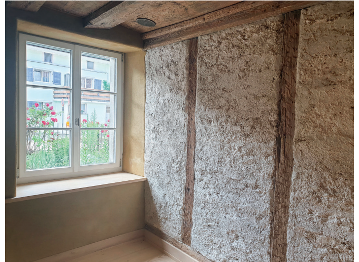
Ein Lehmverputz kennt viele Ausprägungen – hier wird der mit Stroh angereicherte Grundputz ohne Feinputz belassen.
